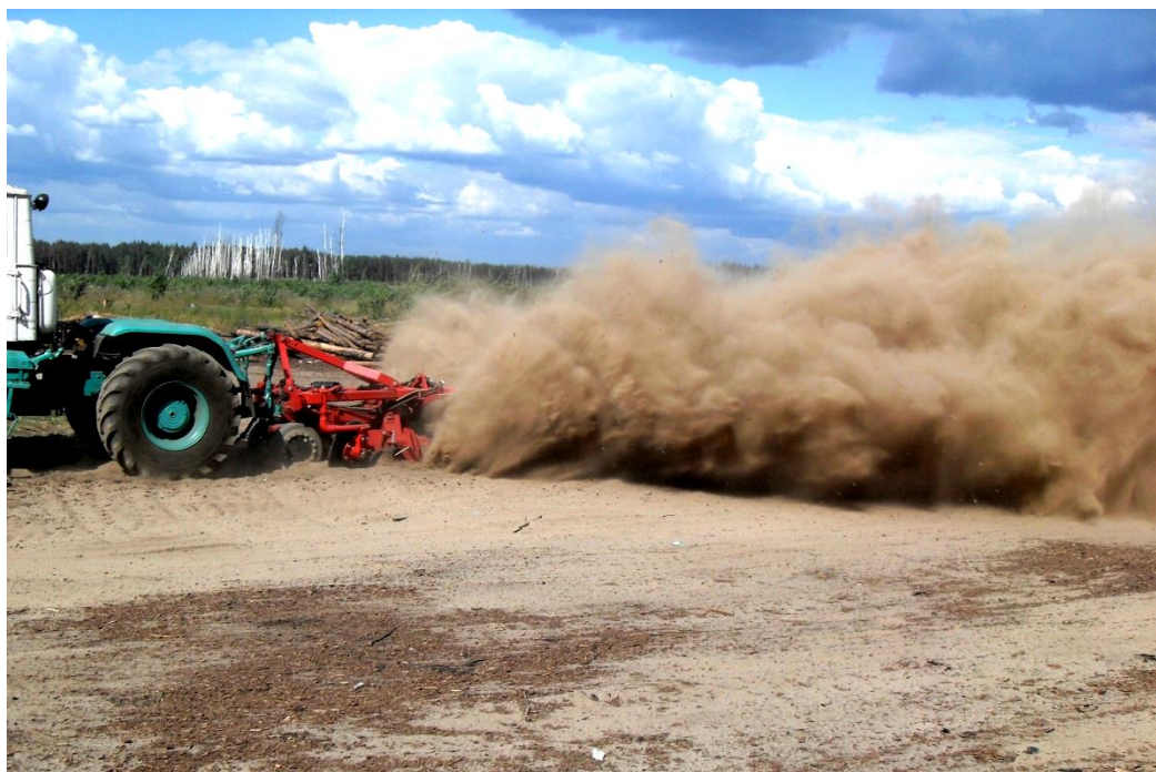
Рисунок 2 – Грунтомет-полосопрокладыватель в работе
