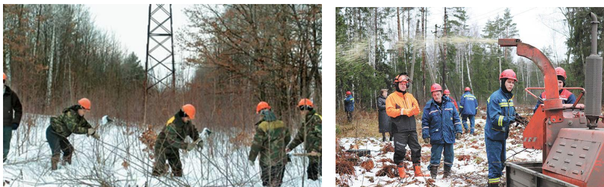
Рисунок 1 – Удаление нежелательной растительности в охранной зоне ВЛ
